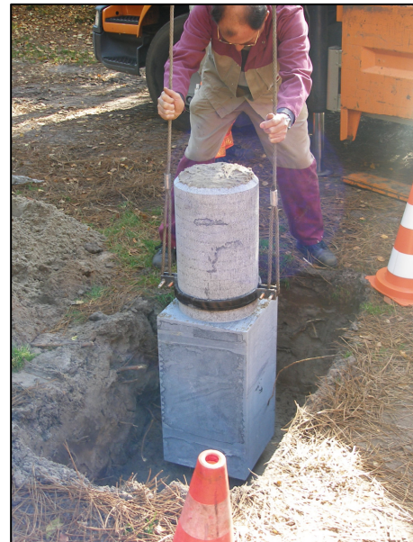
Plaatsing van nieuwe grenssteen nr 260b
