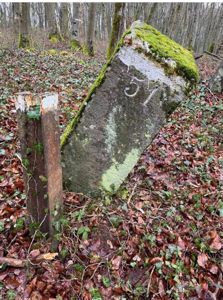
GS 51 is verzakt door een ingestorte mijngang.
