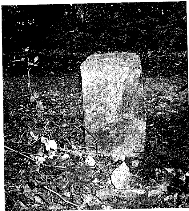
Stark beschädigt: die Nummer 33.
